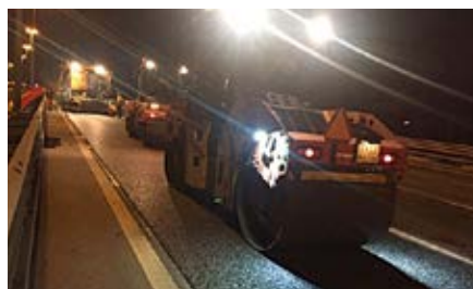
Рисунок 2. Устройство участка из ЩМА смеси «Суперпейв» марки SMA-19 на Кольцевой автомобильной дороге (КАД)
