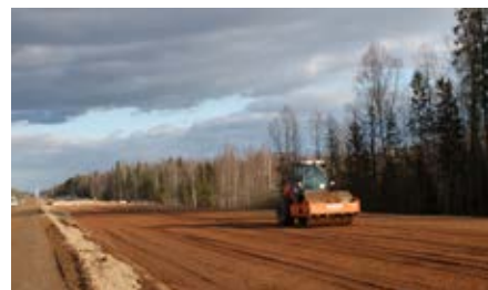
Уплотнение насыпного основания грунтовым виброткатком
