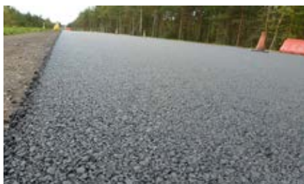
Рисунок 1. Устройство участка из смеси «Суперпейв» марки Sp-19 в Ленинградской области
