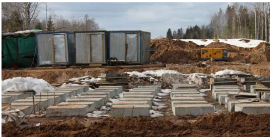
Укрепление грунта с помощью свай (на сваи надеты оголовки)
