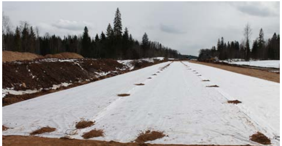
Укладка геотекстиля на подготовленное основание
