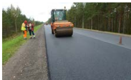
Рисунок 1. Устройство участка из смеси «Суперпейв» марки Sp-19 в Ленинградской области
