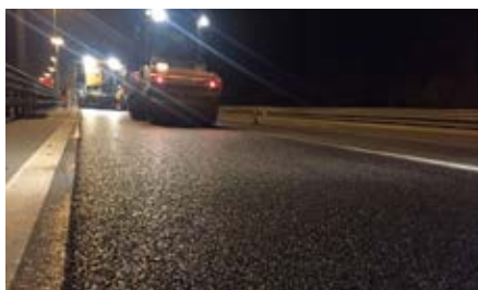
Рисунок 2. Устройство участка из ЩМА смеси «Суперпейв» марки SMA-19 на Кольцевой автомобильной дороге (КАД)
